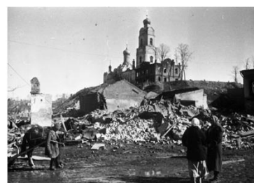
Вид на разрушенные дома и храм во имя Пресвятой Троицы в освобожденной Вязьме. (фото, 1943г.)
