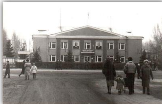
Здание музыкальной школы 1950 г.
