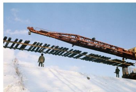
Монтаж железнодорожных путей БАМа 1979 г.
