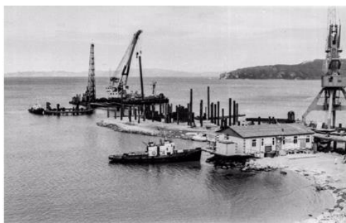
Строительство причала угольного комплекса порта Восточного, 1961 г.
