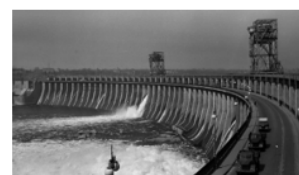
Днепрогэс. На момент ввода в 1932 г. крупнейшая гидроэлектростанция Европы
