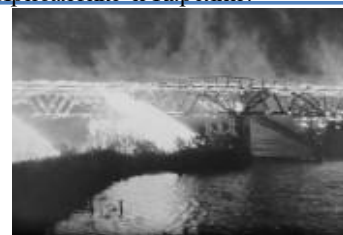
Горящий деревянный железнодорожный мост над рекой "Стыр" на участке железной дороги между городами Сарны и Ковель, подожженный партизанами
