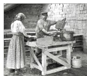
Выделка кирпичей формой на кирпичном заводе
